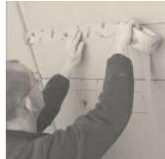
Dampfbremse: Abkleben von Stößen und Überlappungen
