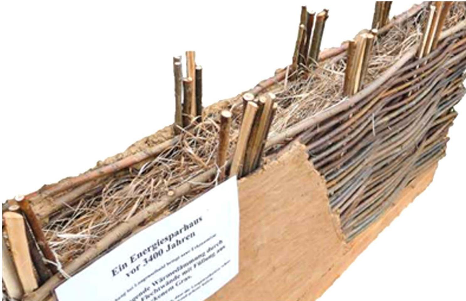
**Mit der zehn Zentimeter dicken Grasfüllung ist der Wärmeschutz verblüffend gut. Der U-Wert liegt zwischen 0,5 und 1,0 W/(m<sup>2</sup>K), je nachdem, wie fest das Gras gestopft wurde.**
